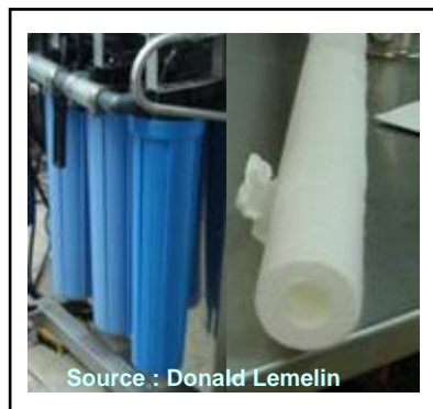
Figure 21 :Caissons et cartouche d'un préfiltre.
